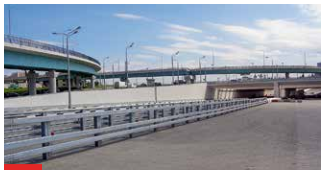
Тоннель под Щелковским шоссе (CBX)
