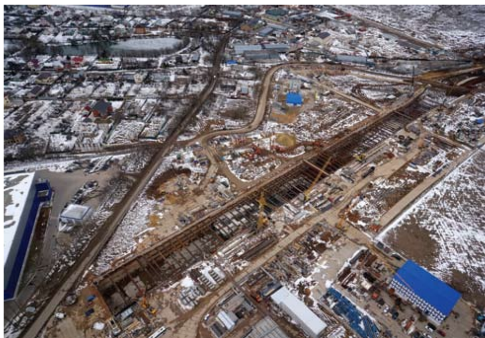
Вид на строительную площадку станции метро «Румянцево»
