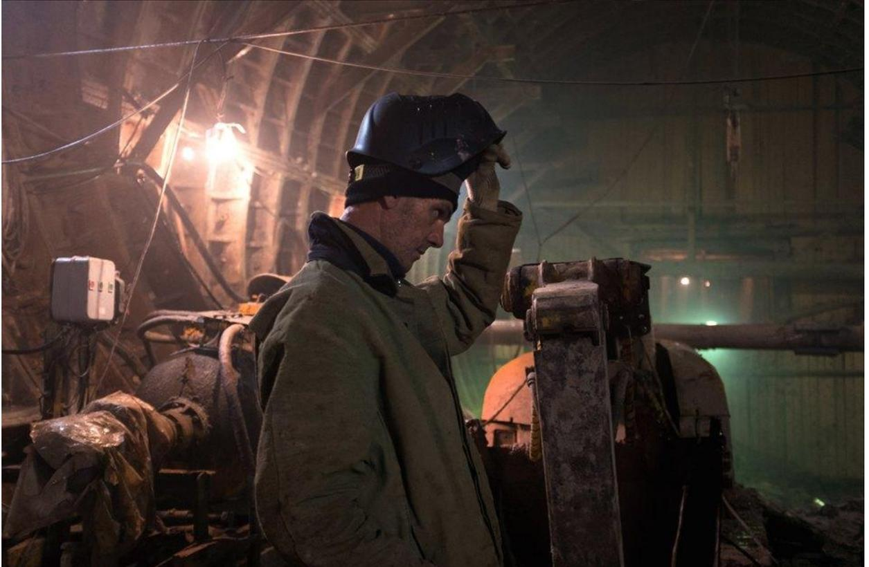
После спуска попадаешь в лабиринт тоннелей. Он появился в результате проведения проходческих работ. По словам начальника участка Павла Калимуллина, сейчас на «Фонвизинской» они завершены уже на 91 %. Осталось поставить 30 колец в левом тоннеле (около 22,5 метра) и в так называемом наклонном ходе. Там будут располагаться эскалаторы. По плану установка колец завершится к 15 ноября. Одно кольцо в среднем устанавливают три дня.
