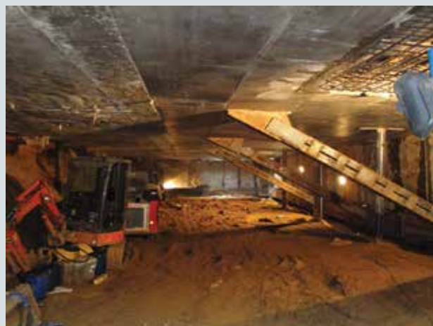
Рис. 3. Разработка грунта под капитальным перекрытием, вес которого передается на «стену в грунте» за счет подкосов
