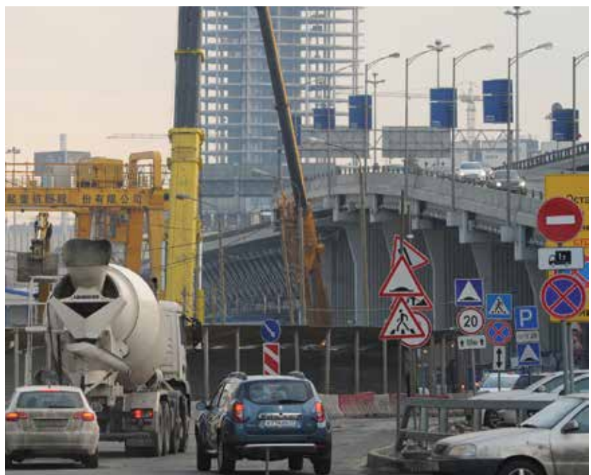
Сегодня строительные работы на магистралях ведутся на 258 объектах
