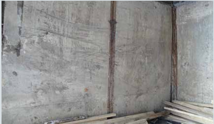
Рис. 7. Несущая капитальная сборно-молитная водонепроницаемая «стена в грунте» из элементов заводского изготовления
