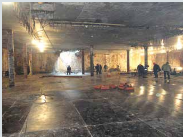
Рис. 2. Бетонирование нижнего капитального перекрытия для крепления котлована глубиной 20 м
