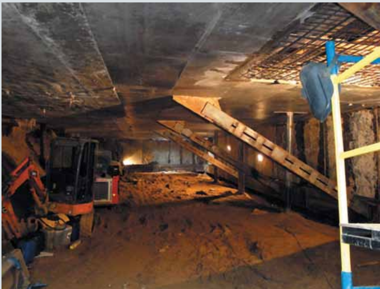
Рис. 4. Пространственная распорная система, включающая подкосы и опирающаяся на грунтовый целик
