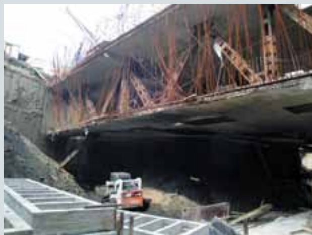
Рис. 6. Большепролетная пространственная распорная система для крепления котлована на Дербеневской ул., 17, опирающаяся на подкосы и грунтовые целики
