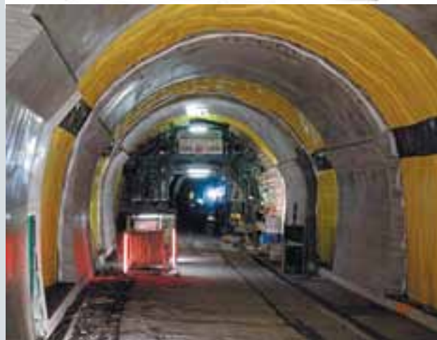
Рис. 7. Обделка автодорожного тоннеля в Ровердо (Roveredo)
