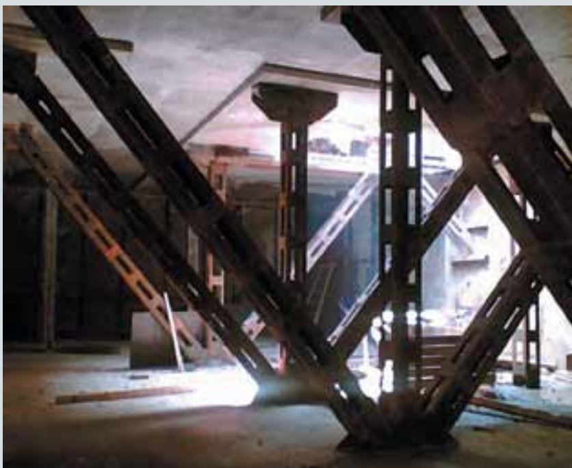
Рис. 1. Пространственная распорная система для крепления котлована гаража на Тургеневской площади
