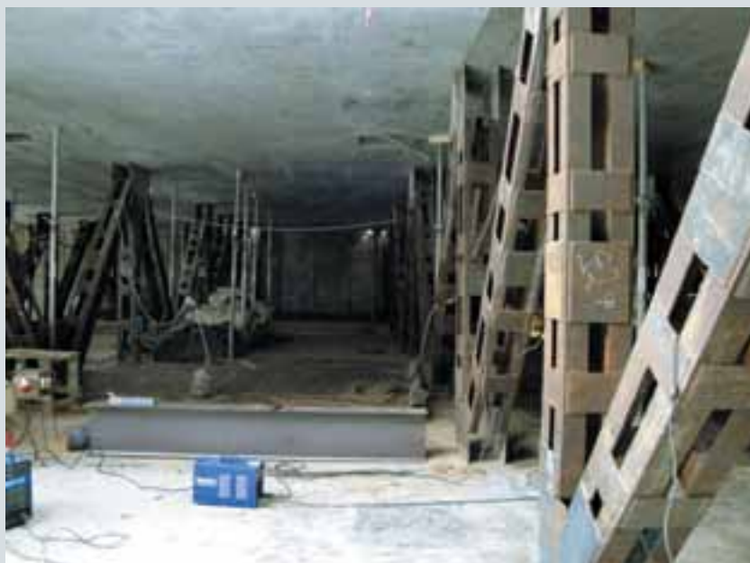
Рис. 3. Большепролетная пространственная распорная система для крепления котлована в Стремянном пер., 29
