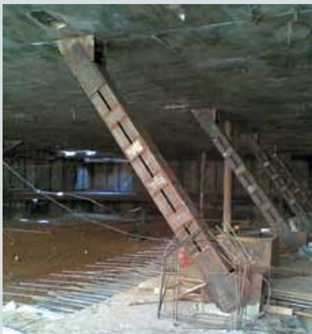
Рис. 5. После выполнения фрагмента фундаментной плиты пространственную распорную систему опирают на нее посредством подкосов
