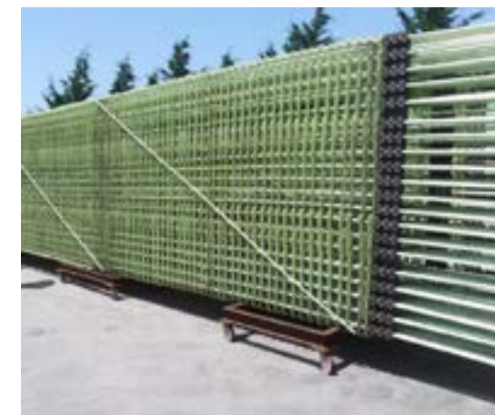
Рис. 1. Объемный каркас для секции «стены в грунте»
