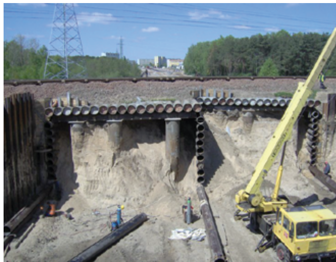
Рис. 2. Пример экрана из труб под железной дорогой
