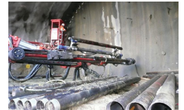
Рис. 5. Выполнение зонта из труб с цементацией
