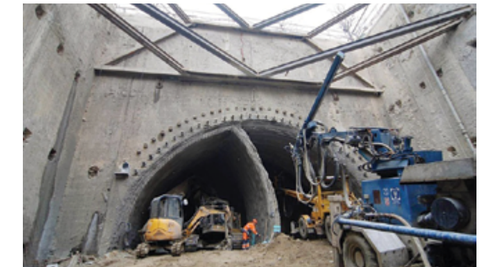
Рис. 7. Выполнение набрызгбетонной временной крепи под защитой зонта
