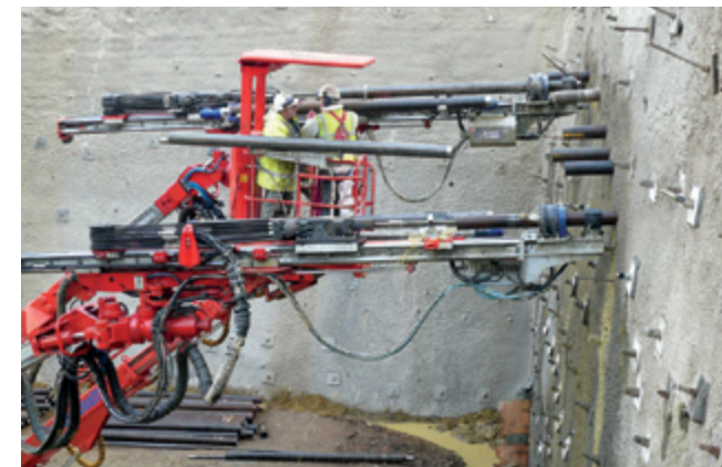
Рис. 5. Выполнение зонта из труб с цементацией
