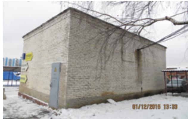
Рис. 2. Часть фасада здания №2, фактическая осадка основания которого превысила 150 мм
