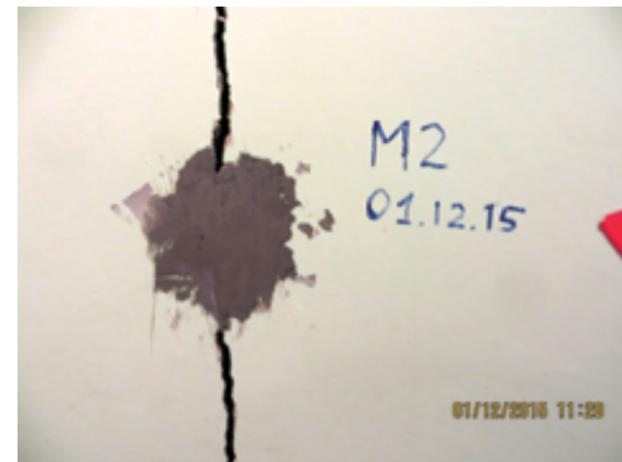
Рис. 5. Трещина в несущей стене здания №1
