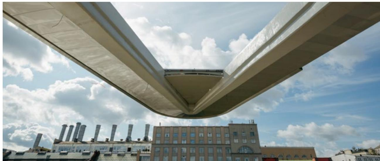
консольная же часть конструкции не имеет опор. Несущая конструкция моста выполнена из предварительно напряженного бетона, декоративные элементы из металла, а сам настил прогулочной зоны — из дерева.
