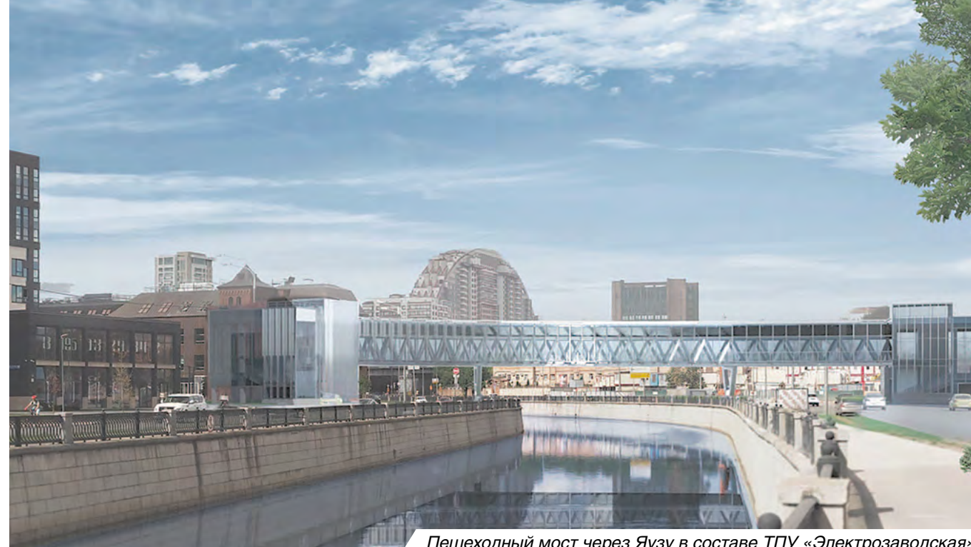
Пешеходный мост через Яузу в составе ТПУ «Электrozаводская»
