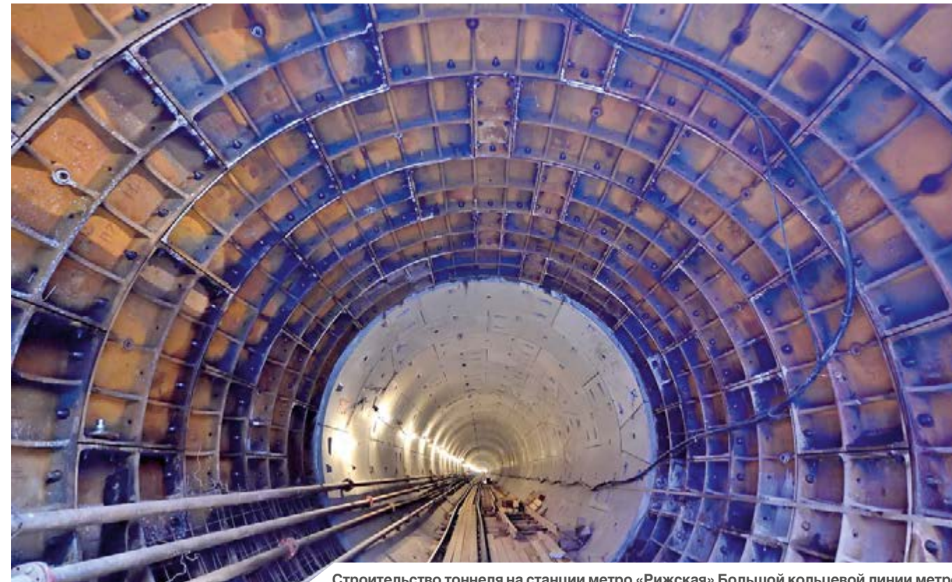
Строительство тоннеля на станции метро «Рижская» Большой кольцевой линии метро
